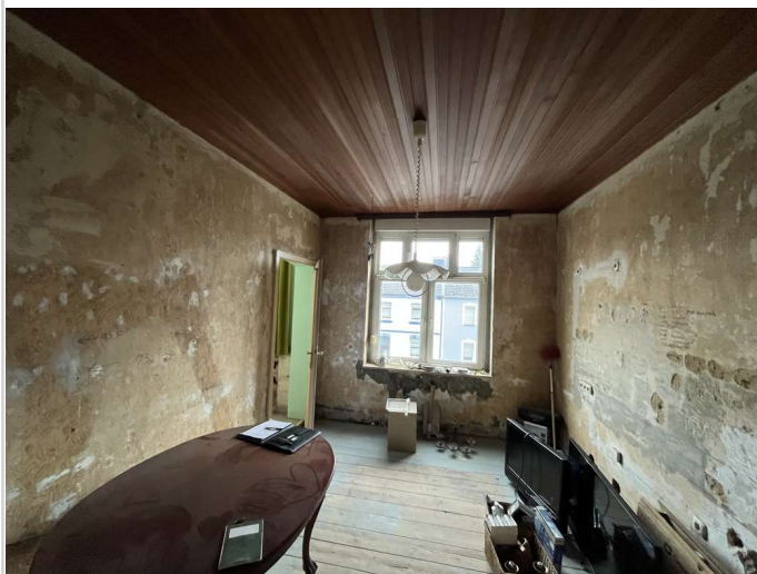
Schlafzimmer OG schon entkernt
