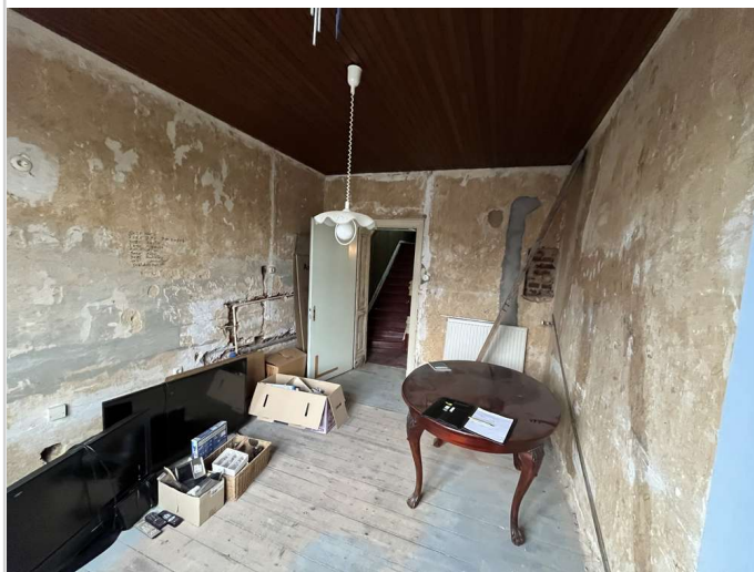
Schlafzimmer/ Küche OG entkern
