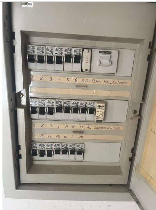
Sicherungskasten erneuert
